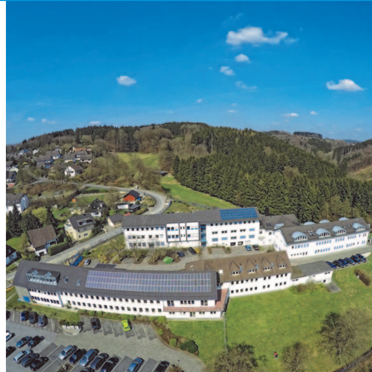
Verwaltungsgebäude in Gammersbach-Niederseßmar
