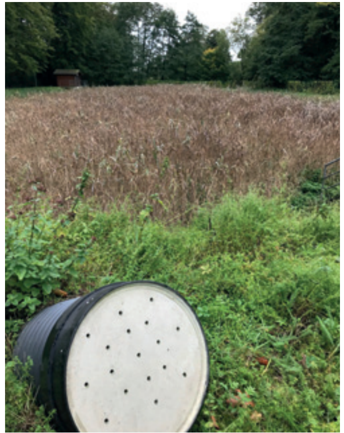
Abb. 49: Drainageöffnung Bechen Schilfbewuchs
