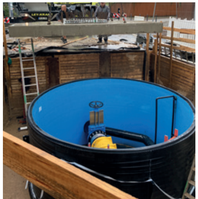
Abb. 33: Einbau der zweigeteilten Stahlbetonabdeckung des Drosselschachtes mithilfe eines Kranes
