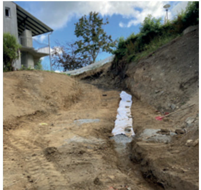
Abb. 35: Neuer Gehweg mit geplanter Entwässerung über die Schulter inkl. hier gebauter Drainage in Kiespackung
