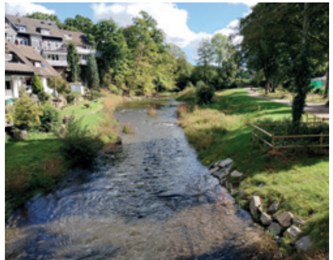
Abb. 5: Nach Rückbau sowie Maßnahmenumsetzung
