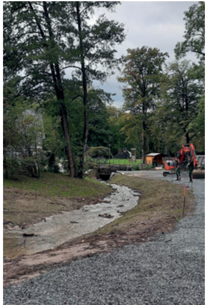
Abb. 3: Oberer Bereich nach der Umgestaltung
