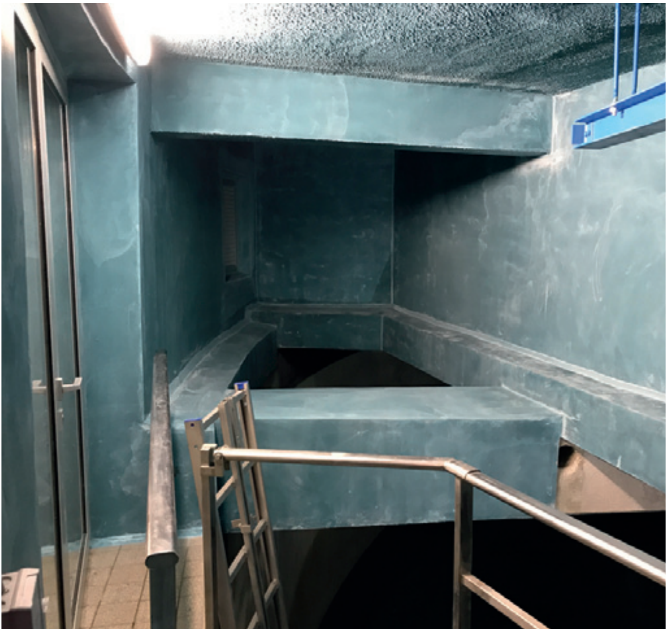
Abb. 54: Beschichtung HB Blasseifen nach Fertigstellung
