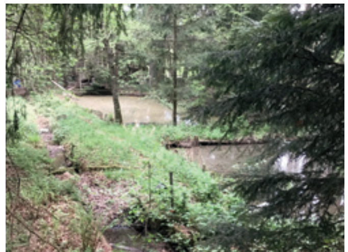
Abb. 6: Teichanlage Weesbach vor Maßnahmenbeginn
