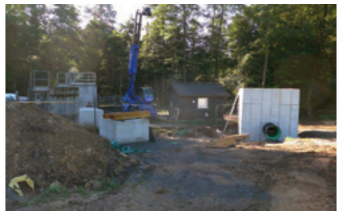
Abb. 42: Neubau Regenrückhaltebecken Morsbach-Alzen
