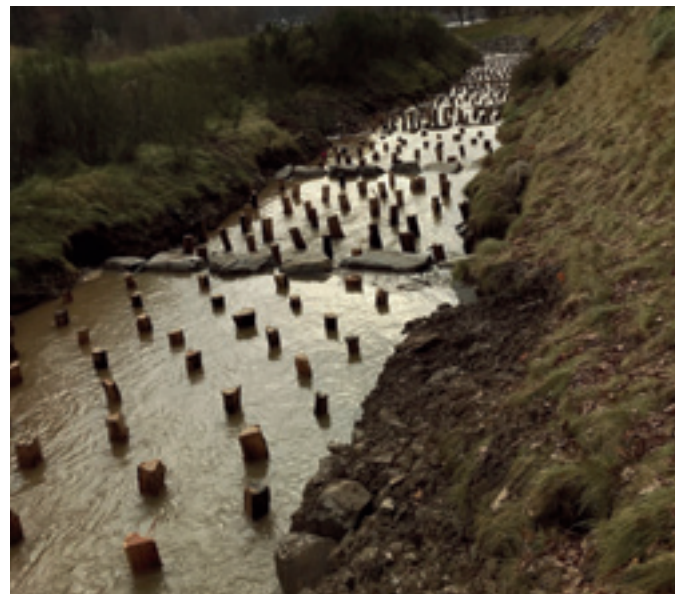
Abb. 14: Seßmarbach im Bau
