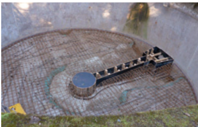
Abb. 41: Neubau Regenrückhaltebecken Morsbach-Alzen
