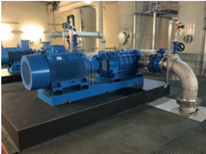
Abb.57 und Abb. 58: Neue Pumpe und eine der erneuerten Armaturen nach Einbau
