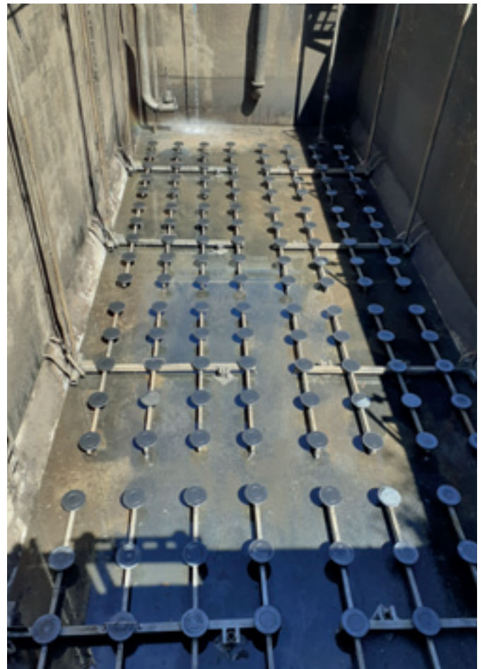
Abb. 25: Kläranlage Eckenhagen nach Belüftertausch
