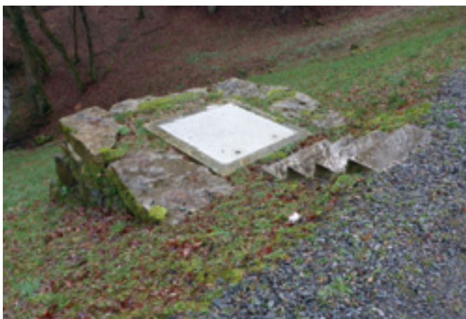
Abb. 17: Kontrollschacht vor der Sanierung
