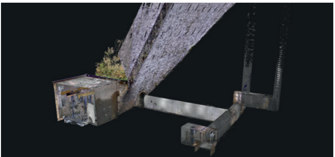
Abb. 65: Aggertalsperre - Ansicht von innen - Schieberhaus und Kontrollgänge
