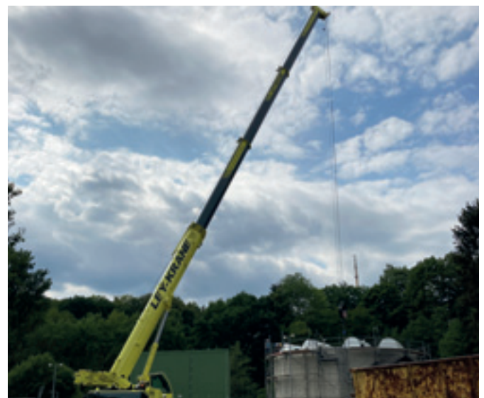
Abb. 30: Montage neue Abdeckung
