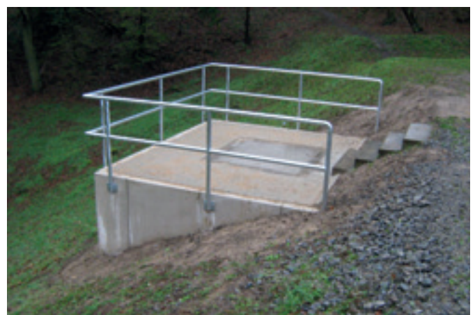
Abb. 18: Kontrollschacht nach der Sanierung
