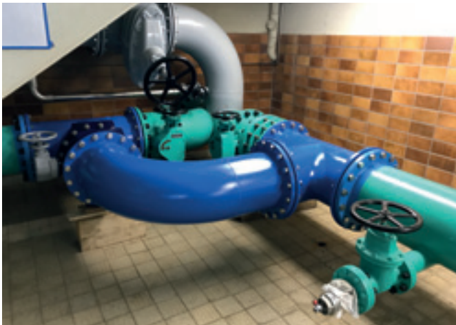
Abb. 55: Notfallpumpe Ommerborn: fertiggestellte Umgehungsleitung im PW Habenichts/ Rhein-Wupper
