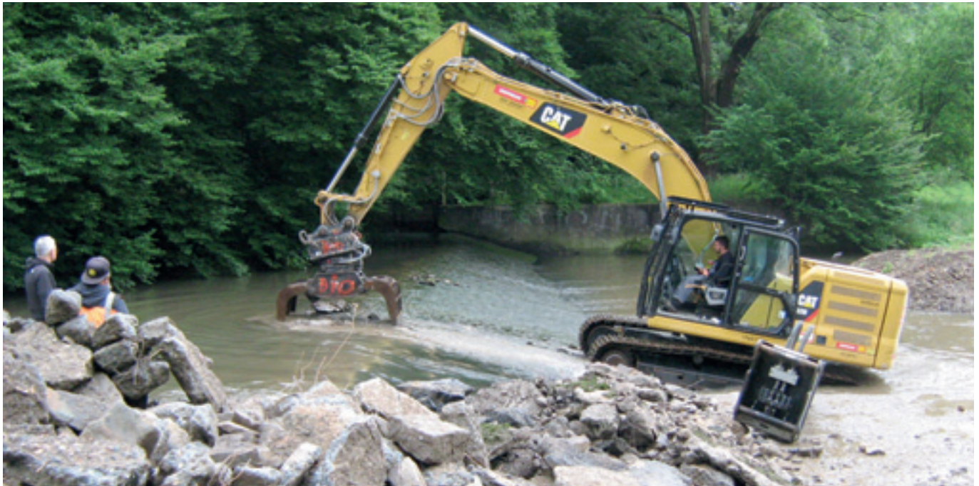
Abb. 16: Wehrrückbau Flocke
