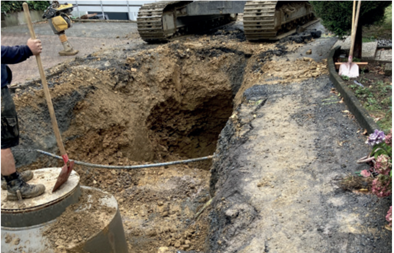
Abb. 37: Kanalbau Aushub mit einigen querenden Hausanschlüssen (Gas, Wasser, Telekom, Vodafone) der Wohnbebauung
