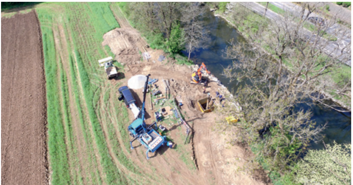
Abb. 60: Tiefpunkt Agger: Baustelle an der RS21
