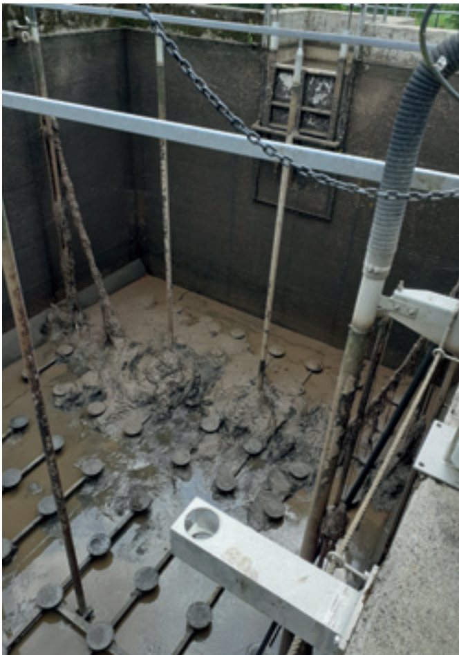
Abb. 24: Kläranlage Eckenhagen vor Belüftertausch
