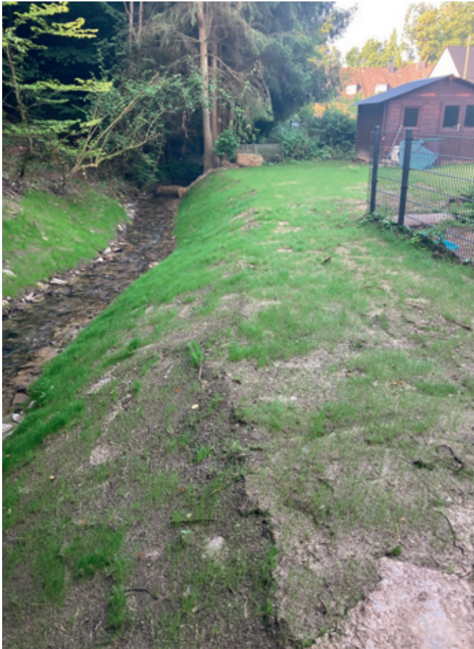
Abb. 13: Abgeflachte und begrünte Uferböschung im Maßnahmenunterlauf
