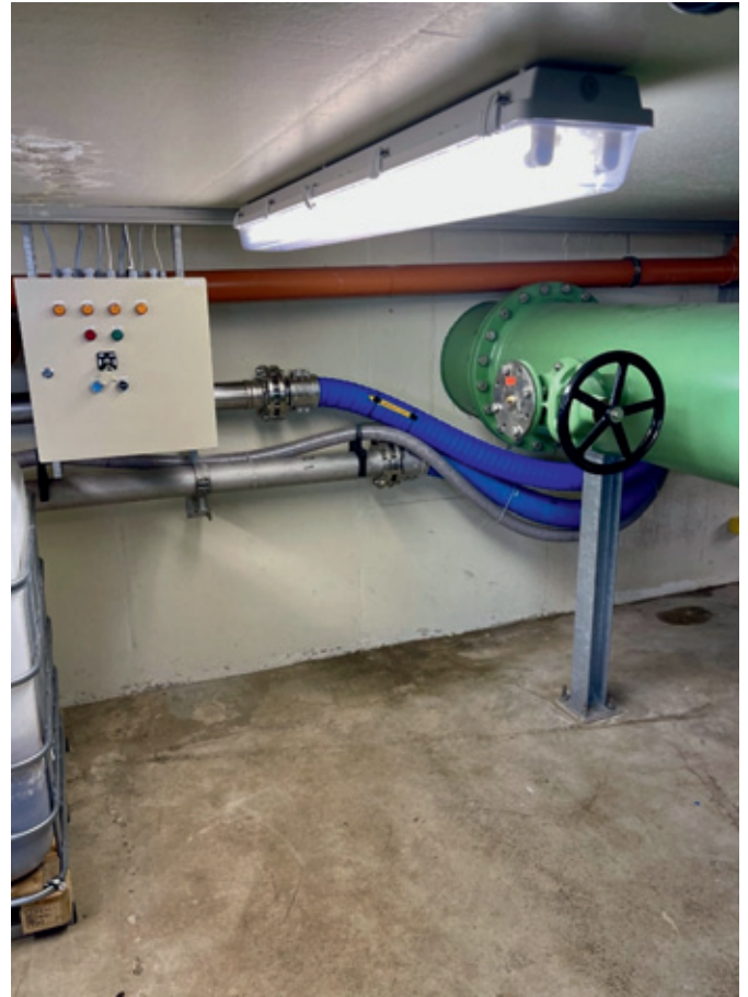
Abb. 71: Übergang vom flexiblen Spezielschlauch auf das Rohrsystem
