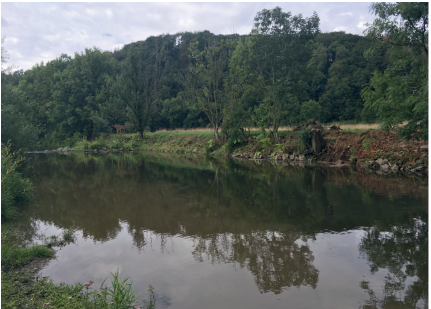
Abb. 1: Vorhandene Uferböschung mit Verbau aus Wasserbausteinen
