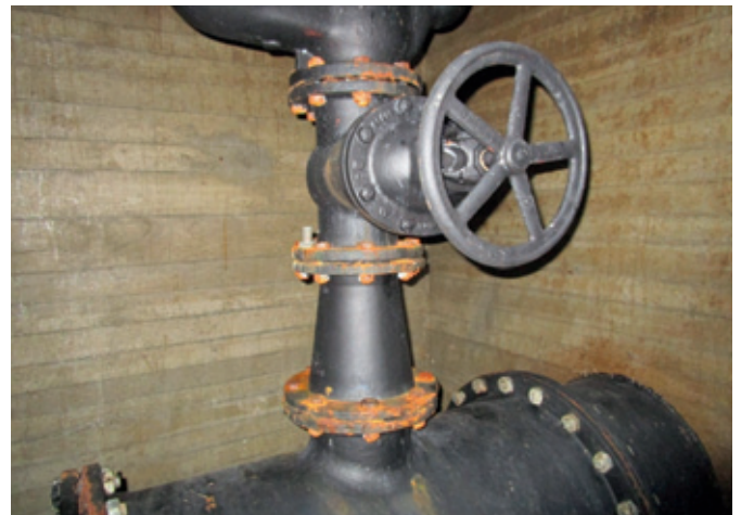
Abb. 93: HPLützingen: Armaturen alt
