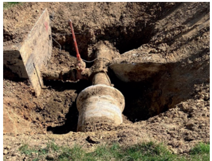
Abb. 84: ÜS Heide: Abgangsschieber alt
