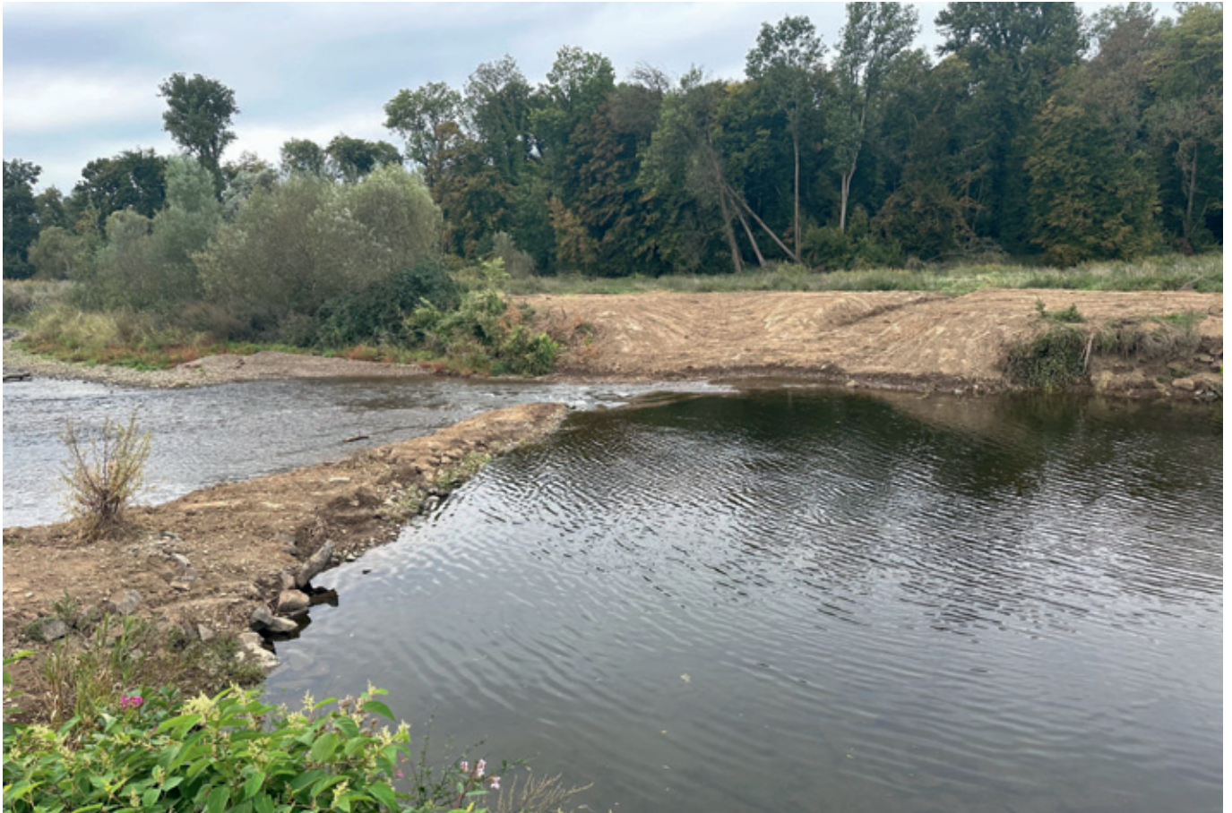
Abb. 5: Massiver Strömungslenker und Geländevertiefung im Vorland
