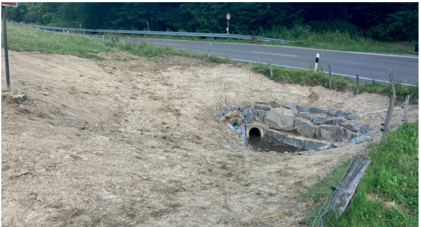
Abb. 8: namenloses Nebengewässer in Lindlar-Süttenbach, Absicherung der Einleitstelle durch Ertüchtigung des Uferverbau
