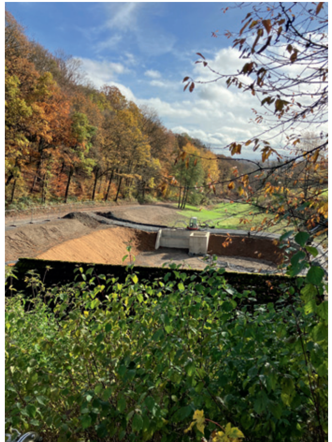
Abb. 47: Neubau Regenüberlaufbecken Morsbach-Lichtenberg
