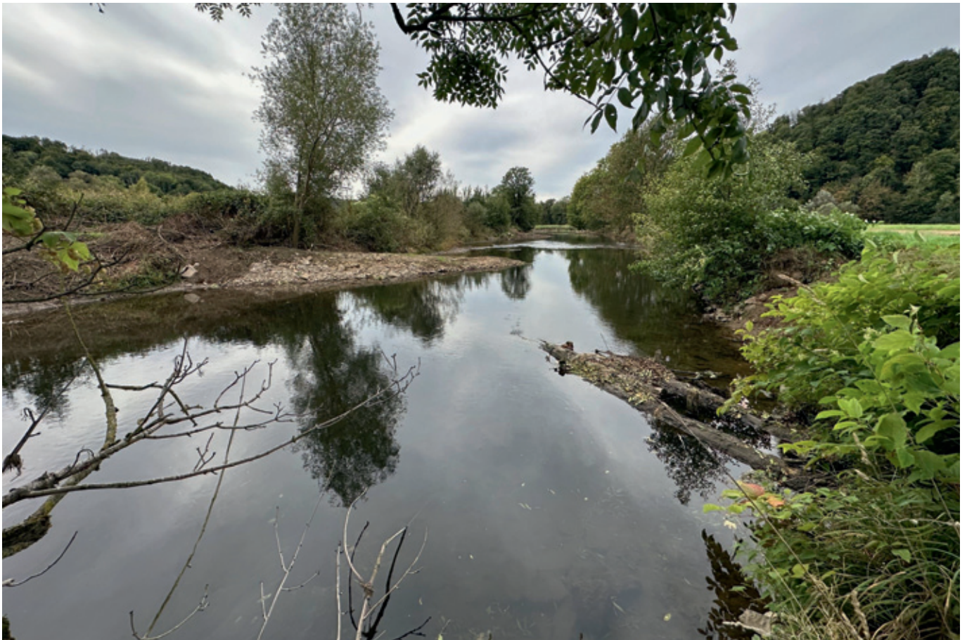
Abb. 4: links im Bild ein Strömungslenker aus Wasserbausteinen, rechts im Bild Totholzbesatz
