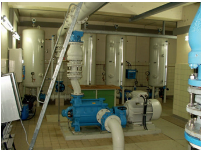
Abb. 79: PW Spreitgen: Pumpe 1 „Alt“ und Formstücke Stahl-Fraizinc-Beschichtung
