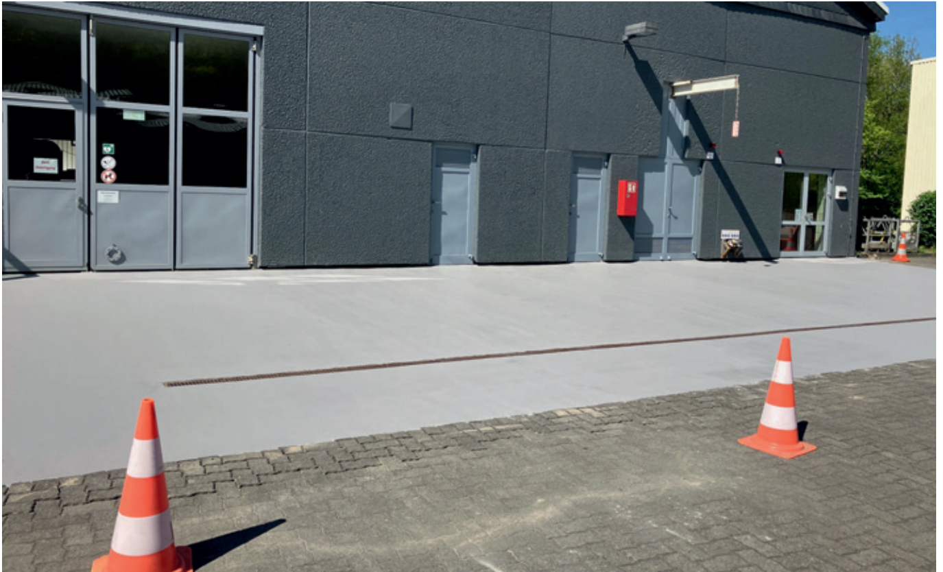
Abb. 102: Bauzustand Abfüllplatz WWA nach Ertüchtigung der Oberfläche
