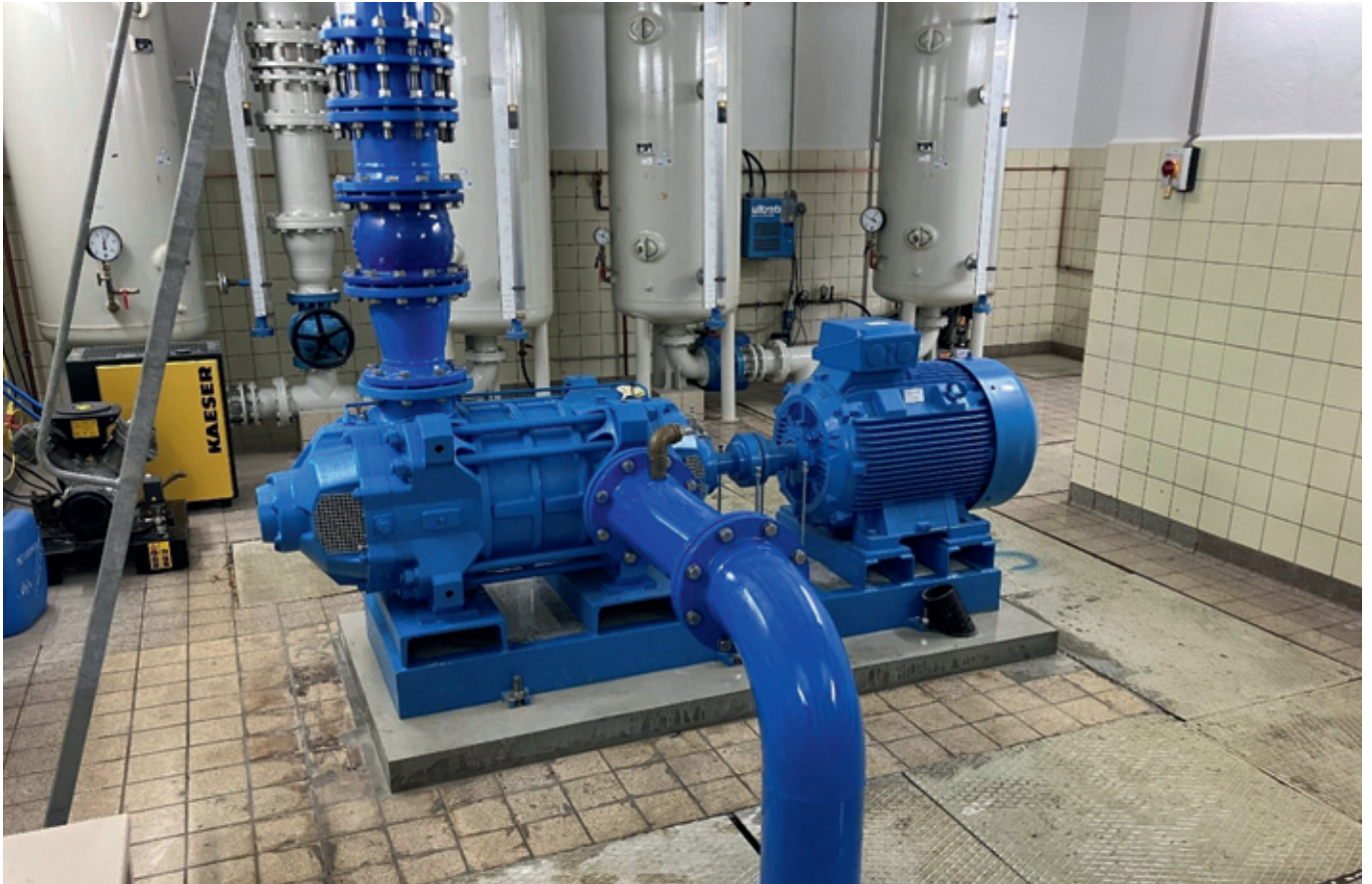
Abb. 81: PW Spreitgen: Pumpe und Saugseite neu
