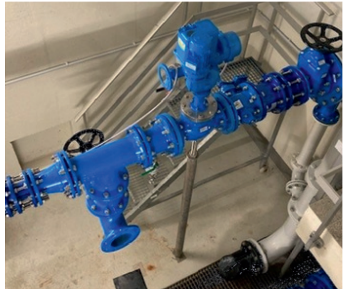
Abb. 77: HB Hohbusch: Erneuerte Armaturenstrecke Zulaufleitung
