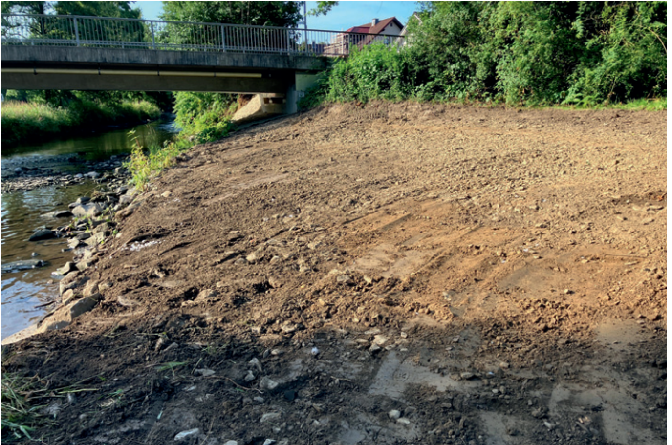
Abb. 9: Agger in Gummersbach-Brunohl, Aufweitung des Abflussprofils durch Räumung eines Brückenfeldes und Geländeanpassung an bestehendem Vorland
