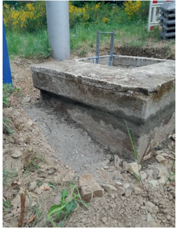
Abb. 97: HP Lützingen: Erneuerung Schachtabdeckung
