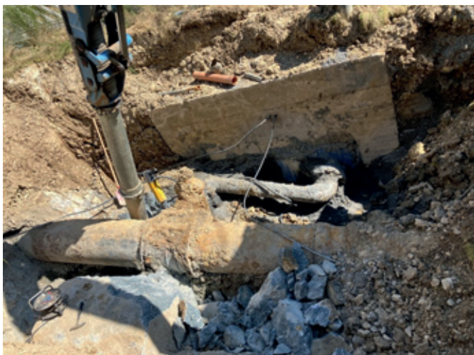
Abb. 88: ÜS Erblingen: Abgangsschieber alt
