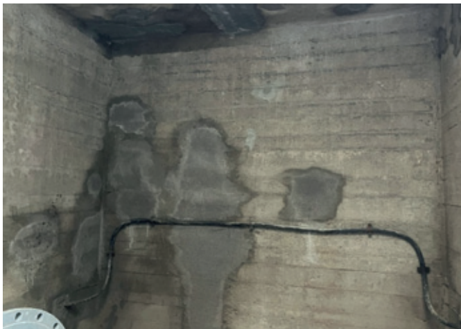
Abb. 92: HPLützingen: Betoninstandsetzung
