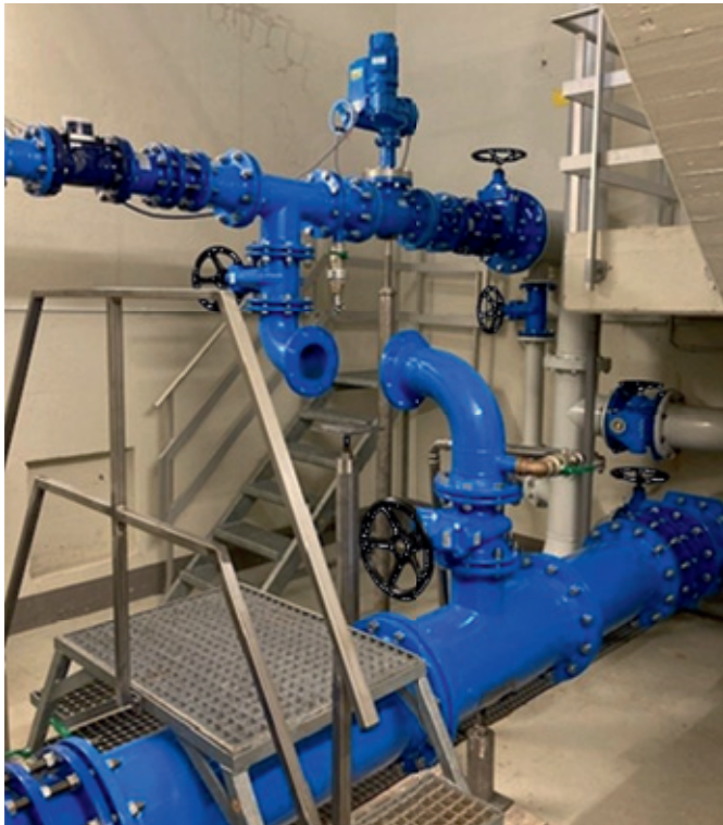
Abb. 76: HB Hohbusch: Erneuerte Armaturenstrecke Zu- und Ablaufleitung
