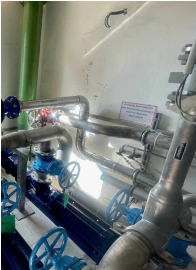
Abb. 73 und 74: Angepasste Rohrleitungsführung im vorhandenen Bestand
