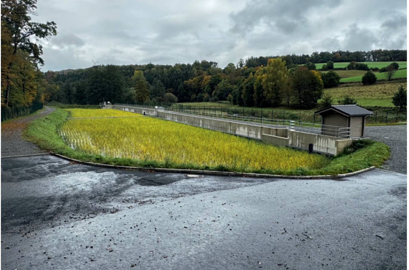
Abb. 45: Retentionsbodenfilterbecken KA Homburg-Bröl Okt.2025
