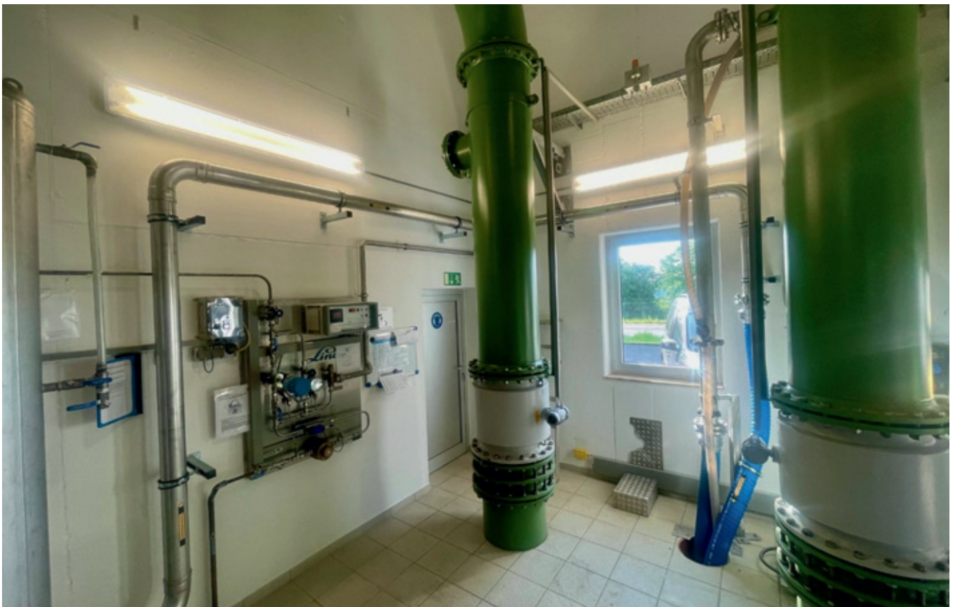
Abb. 72: Neue Leitungsführung vom Druckbehälter zur Deckendurchführung zur Rohwasserzuleitung
