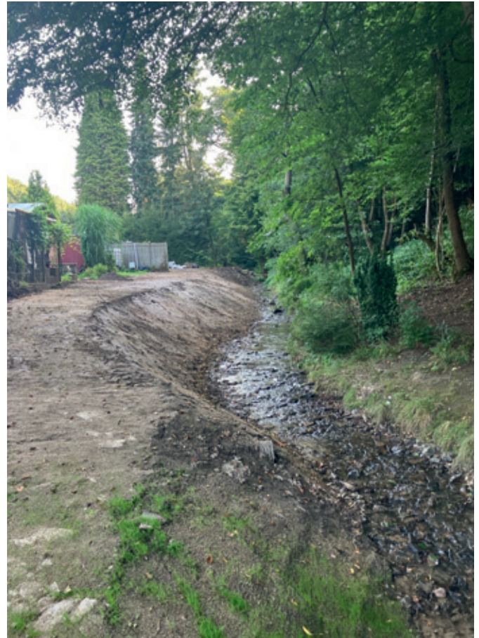
Abb. 14: Aufgeweitete Gewässersohle und abgeflachte Uferböschung im Maßnahmenoberlauf
