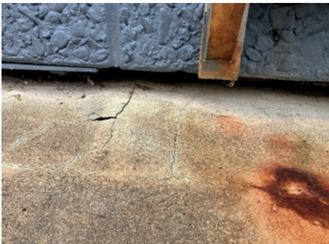
Abb. 101: vorhandene Ablagerungsrückstände von Chemikallieferungen auf dem Abfüllplatz
