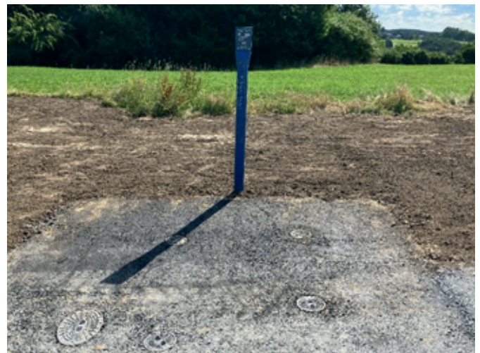
Abb. 86: ÜS Heide: Schiebergruppe nach Fertigstellung
