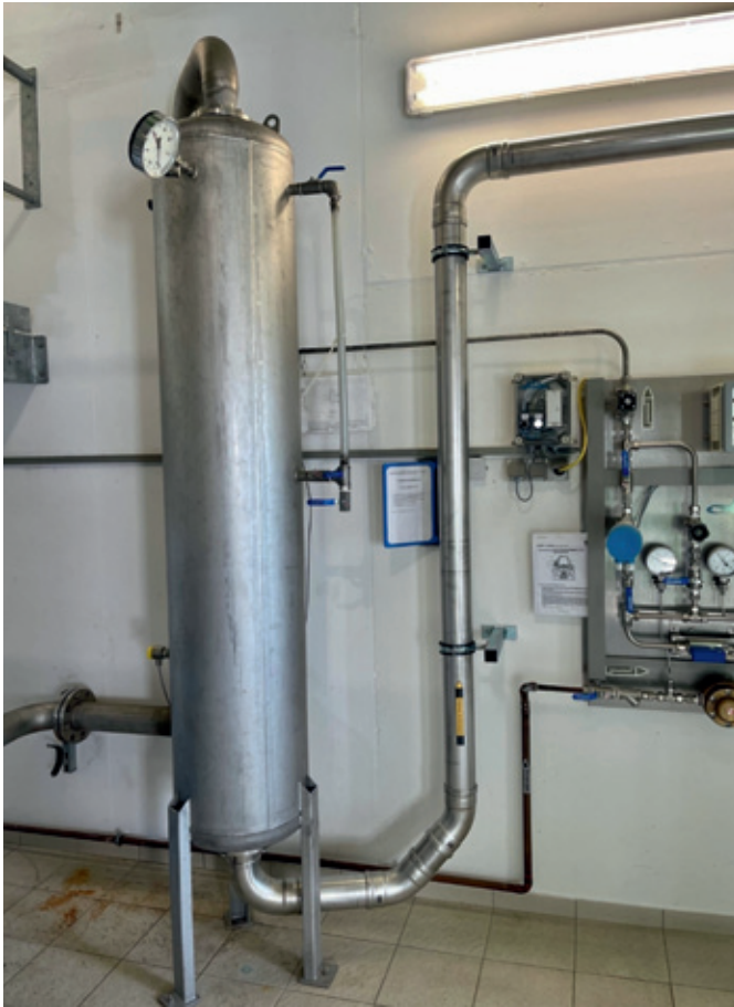
Abb. 70: Druckbehälter CO 2 -Dosierstrecke, Wasserwerk Erlenhagen
