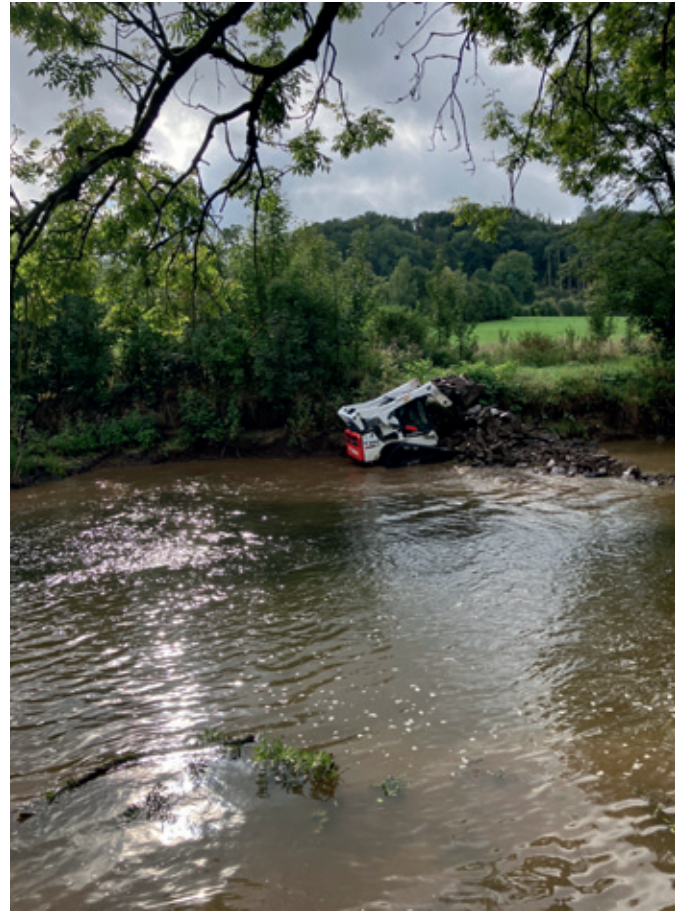
Abb. 3: Errichtung eines Strömungslenkers
