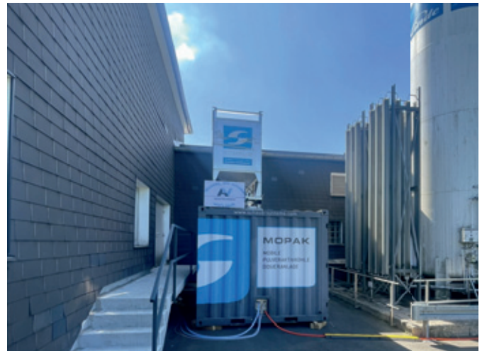
Abb. 66: Mobile Pulveraktivkohleanlage einschl. austauschbarem mobilen Silo (MOPAK)
