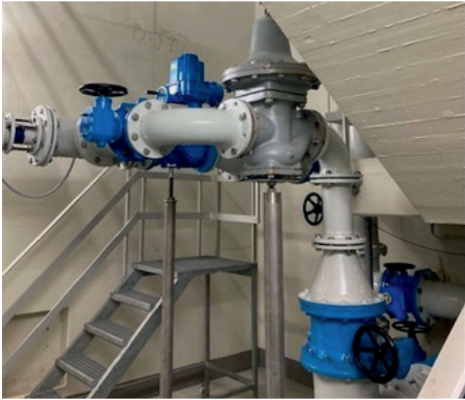
Abb. 75: HB Hohbusch: vorhandene Zu- und Ablaufleitung im Vorraum der Wasserkammer
