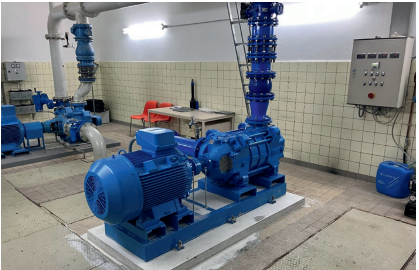
Abb. 82: PW Spreitgen: Pumpfundament fertig vergossen
