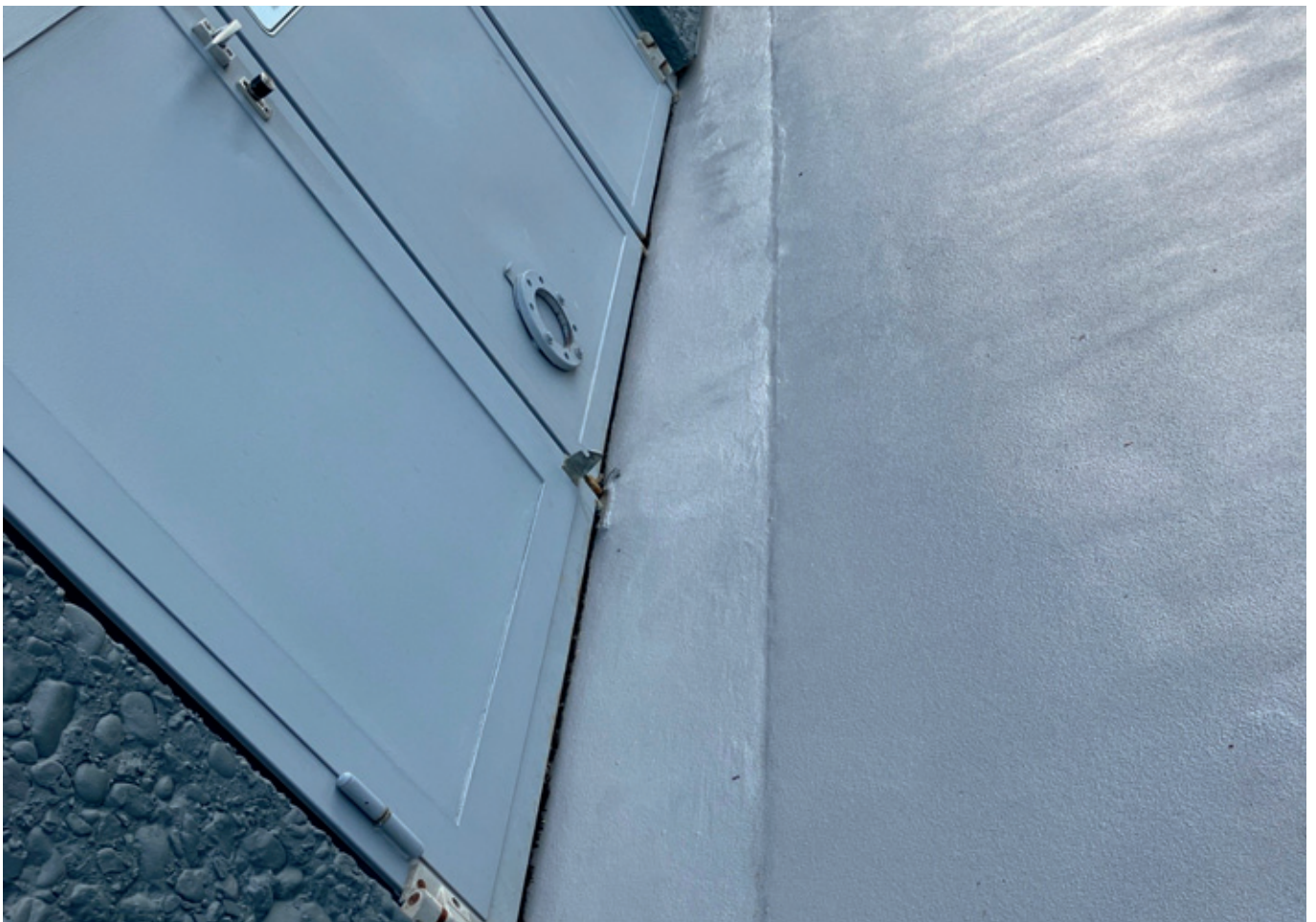
Abb. 103: Fertiggestellter Abfüllplatz mit Oberflächenversiegelung und ausgebildetem Übergang zum Bauwerk
