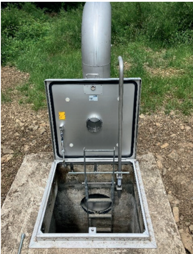
Abb. 98: HP Lützingen: Erneuerung Schachtabdeckung
