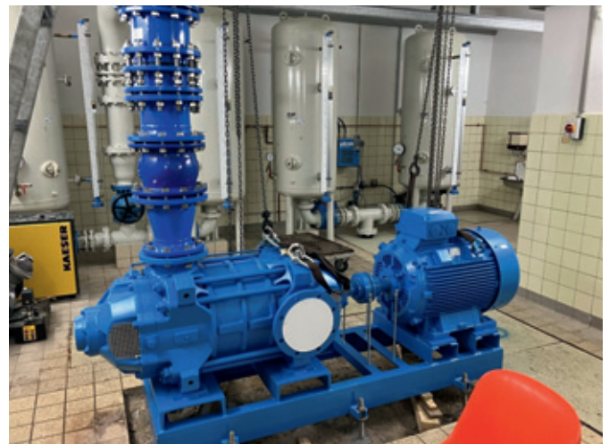
Abb. 80: PW Spreitgen: Pumpe und Druckseite neu
