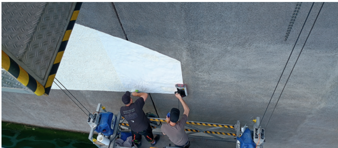
Abb. 32: Verklebung der Folie mit der Mauer durch Heißluft vom Hängegerüst
