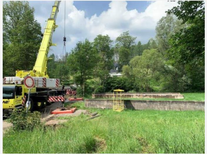
Nach Demontage der korrodierten Auflagerträger ...
