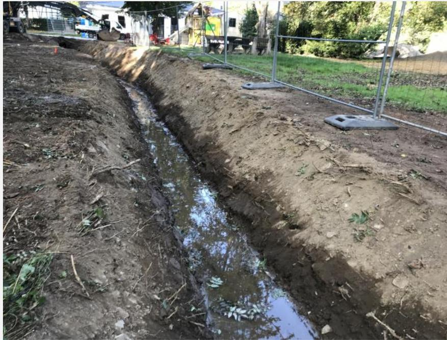
**Abb. 5** Mündungsbereich des Lambachs während der Entrohrung und Offenlegung
