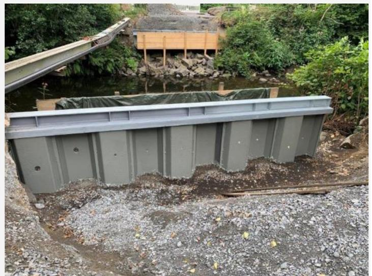
... und Sandstrahlen der Spundwände konnten die neuen verstärkten Träger eingebaut und mit Korrosionsschutz versehen werden.
