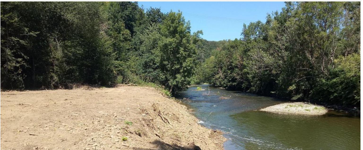
**Abb. 1** Uferfreistellung zur Unterstützung einer eigendynamischen Formung der Agger auf der Maßnahmenfläche
