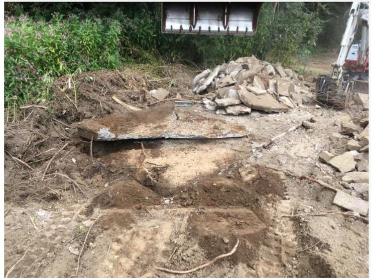
**Abb. 2** Entfernung von zahlreiche Betonplatten des ehemaligen Campingplatzes zur Begünstigung einer standortgerechten Auwaldentwicklung im Maßnahmenbereich
