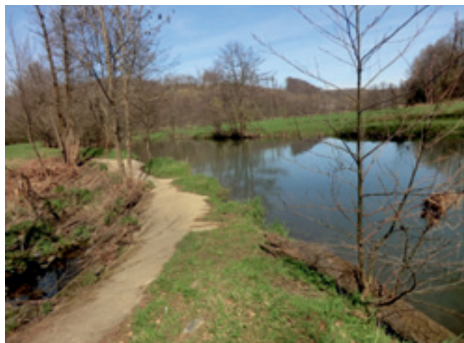
Abb. 9: Betonierte Überlaufschwelle und Staubereich vor dem Rückbau
