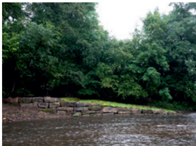
Abb. 11: Aus Denkmalschutzgründen erhaltener und gesicherter Wehrrest. Zur Sicherung wurden im Wehrkörper verbaute Findlinge wiederverwendet
