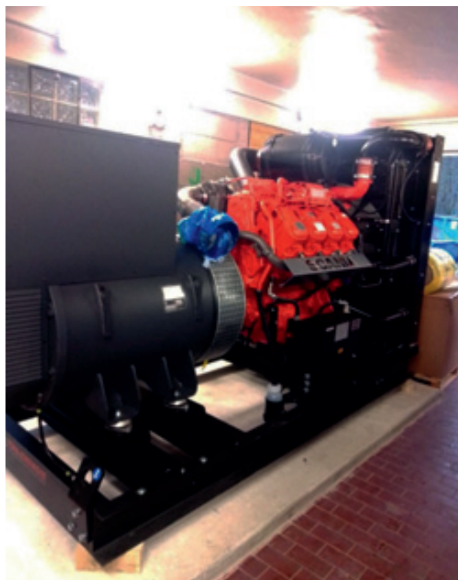
Abb. 58: Aggregat NEA am PW Genkel
