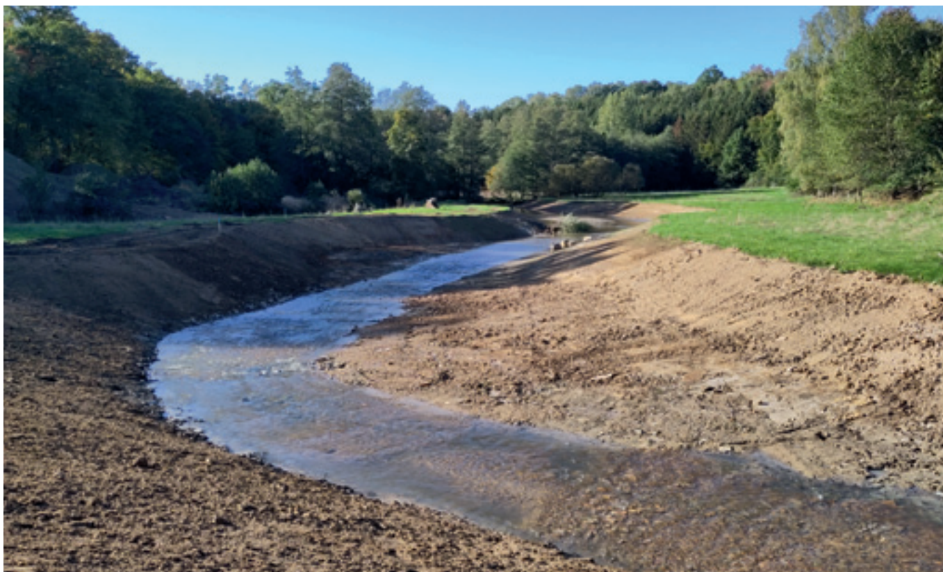
Abb. 5: Neue, leitbildgerechte Gewässertrasse direkt nach Abschluss der Bauarbeiten
