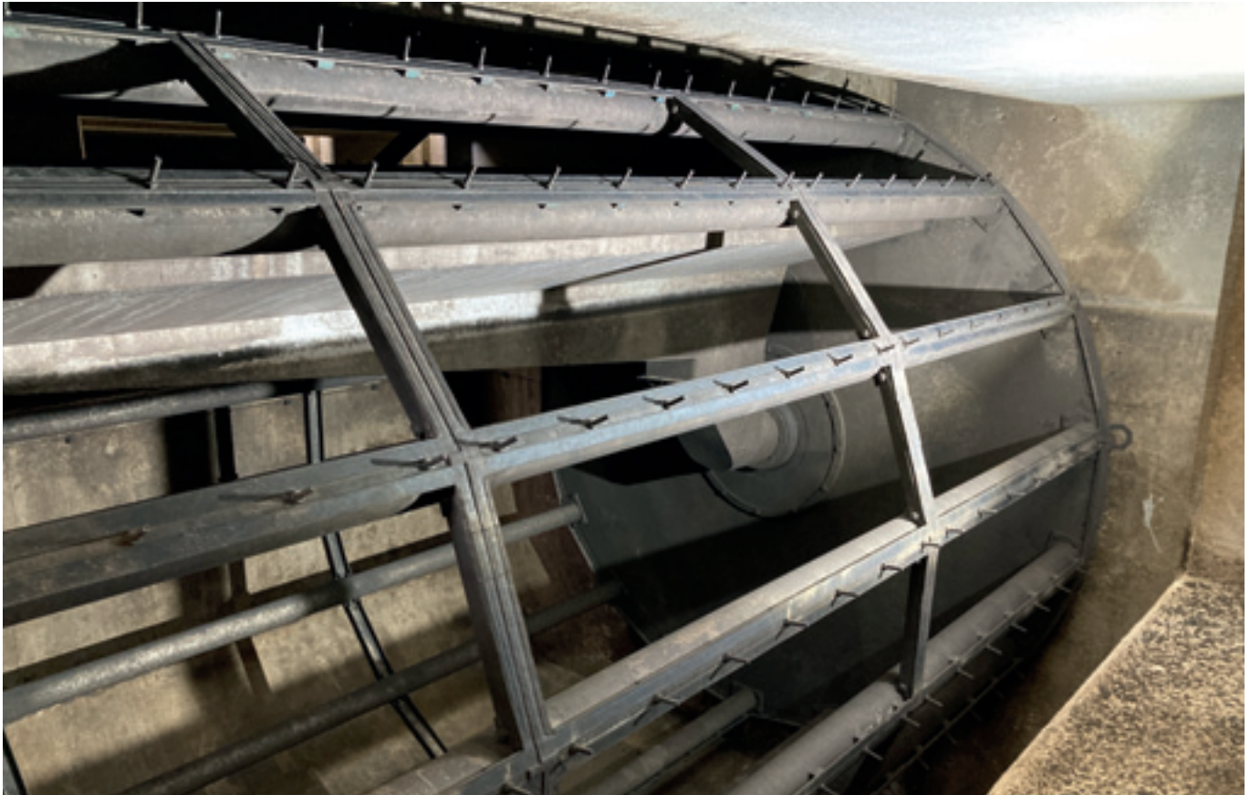
Abb. 74: Siebtrommel ohne Siebkörbe vor der Zementmörtelbeschichtung
