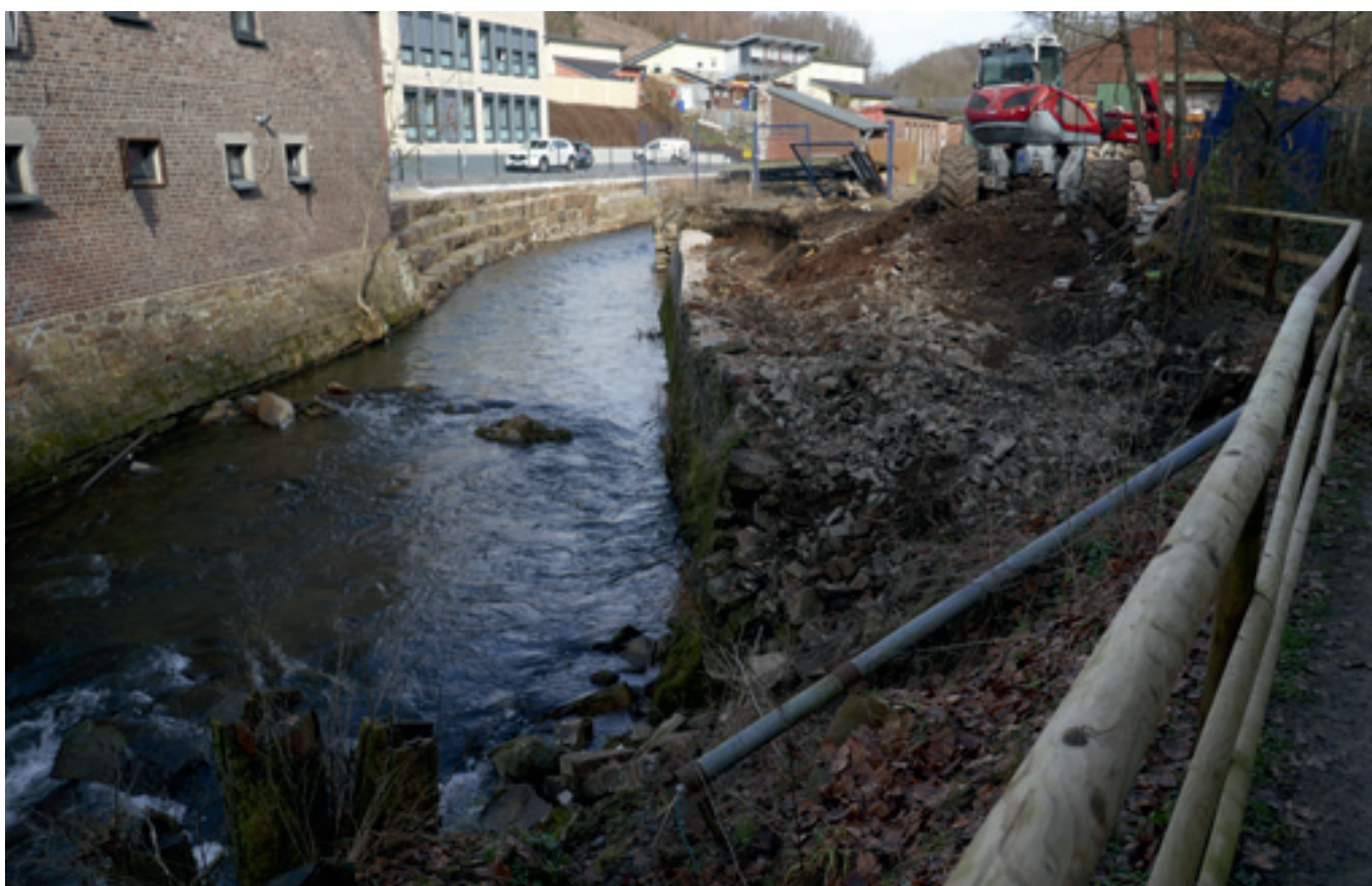
Abb. 20: Situation nach Gebäude-Abriss am 22.02.2023
