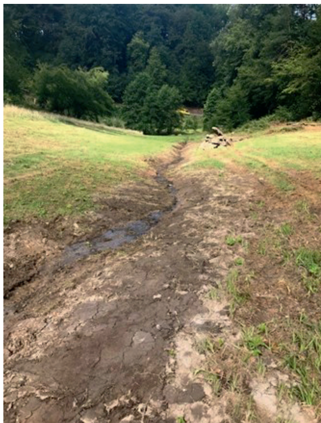
Abb. 23: Zustand des Gewässers nach Beendigung der Bauarbeiten
