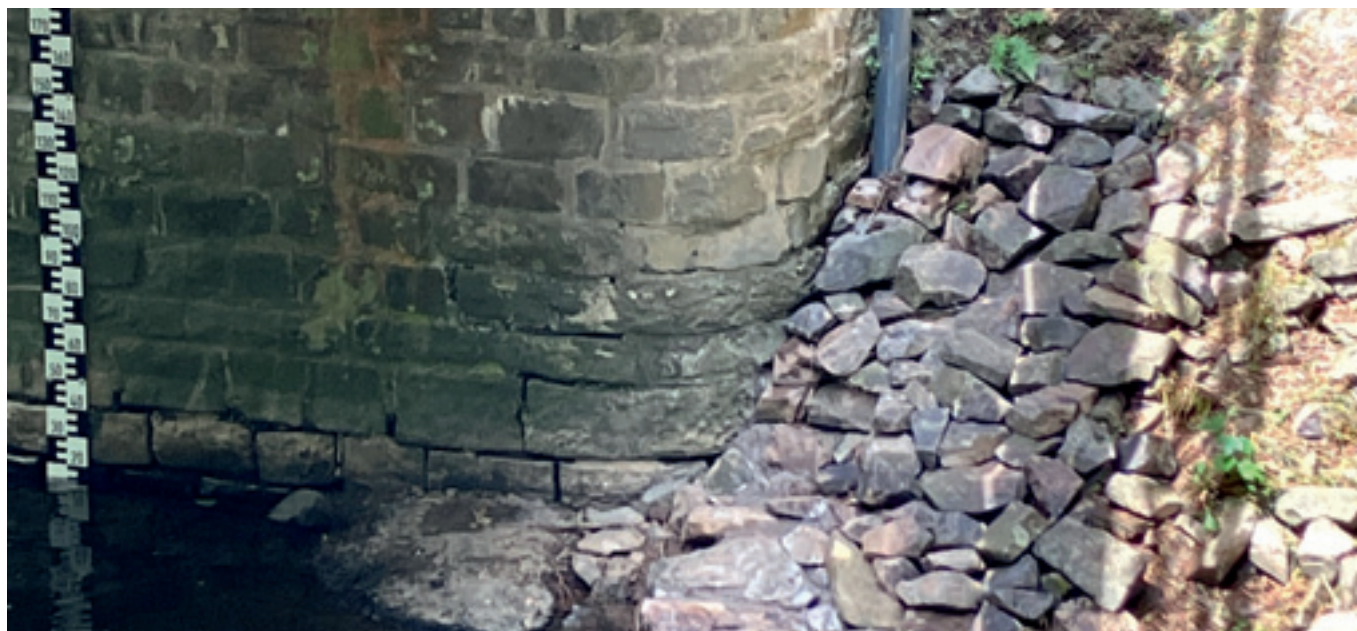
Abb. 29: Pegellatte und Pegelrohr im Endzustand
