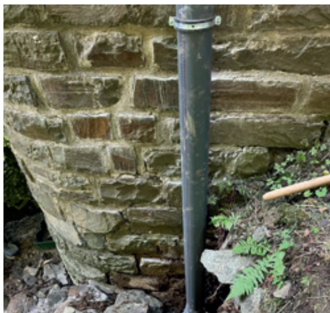
Abb. 27 und 28: Einbau des Pegelrohres an Widerlager und Brückengeländer
