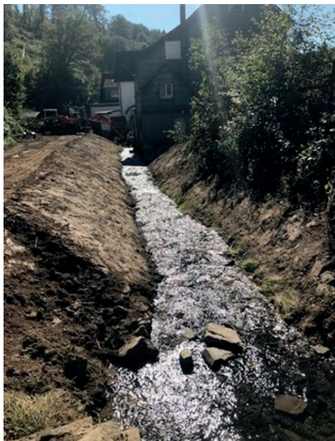
Abb. 16: Situation nach Beendigung der Hochwasserpräventionsmaßnahme
