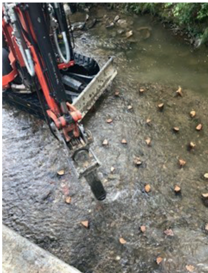
Abb. 18: Einbau der Eichenspaltpfähle mittels Mobilbagger
