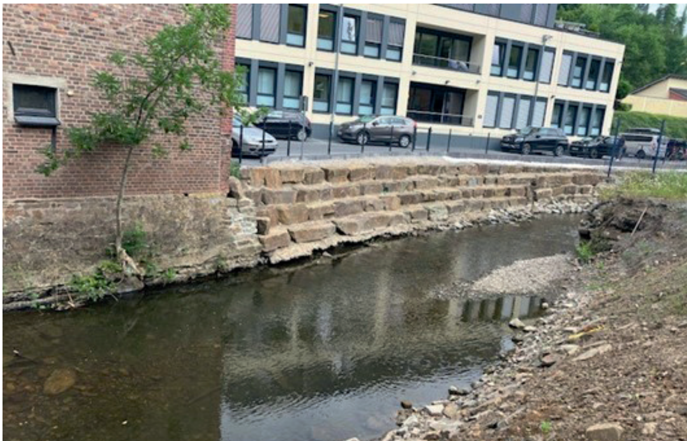
Abb. 21: Situation nach Beendigung der Arbeiten
