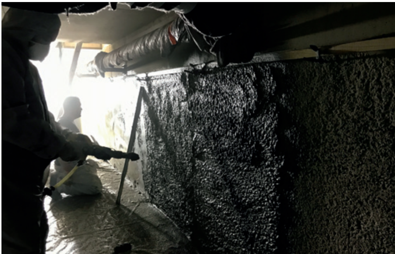
Abb. 77: Beschichtung der Wände im Nassspritzverfahren
