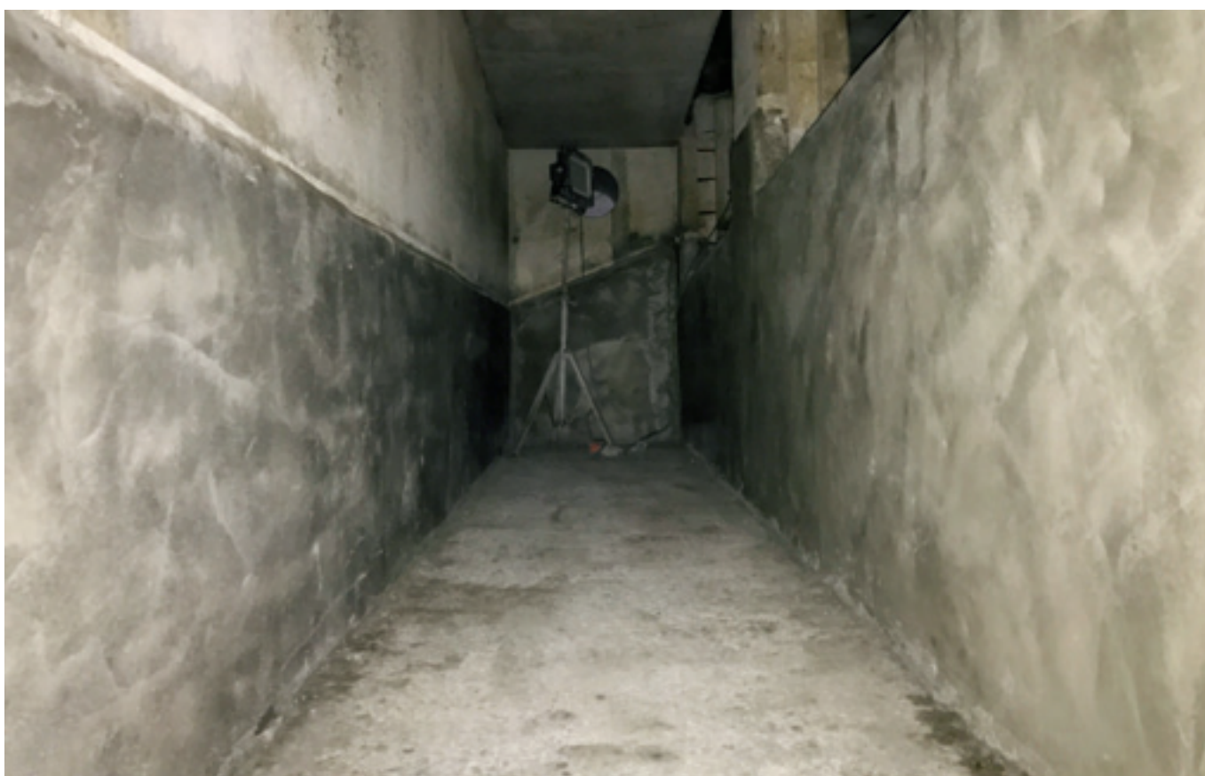
Abb. 78: Wand und Bodenflächen nach der Beschichtung (Ablaufrinne)
