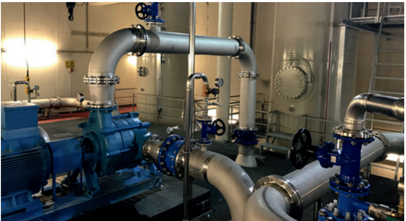
Abb. 80: PW Bredenbruch, Saug- und Druckseite DN 300, Edelstahl
