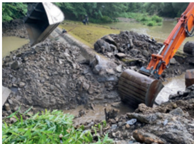
Abb. 10: Abriss des Wehrkörpers
