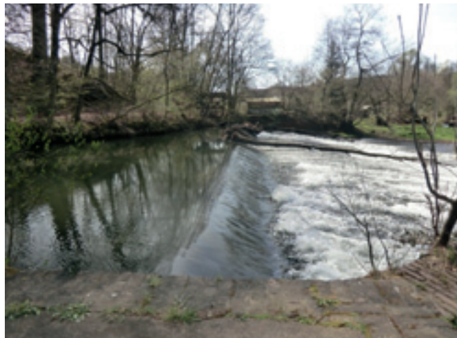
Abb. 8: Wehrkörper vor dem Rückbau. Die ökologische Durchgängigkeit ist nicht gegeben
