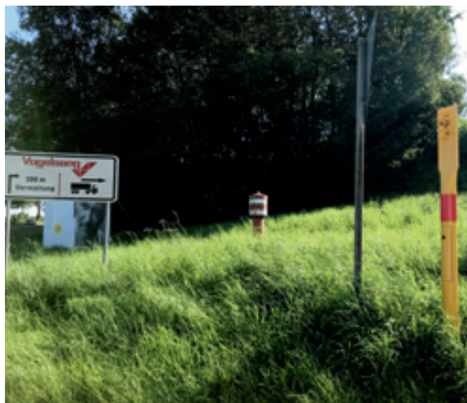
Abb. 82: ÜH Kalsbach, alter Überflurhydrant
