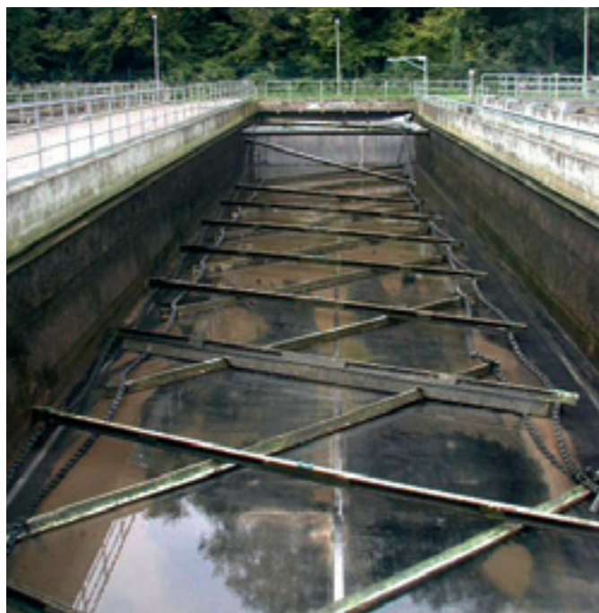
Abb. 35: Balkenräumerschaden 2009
