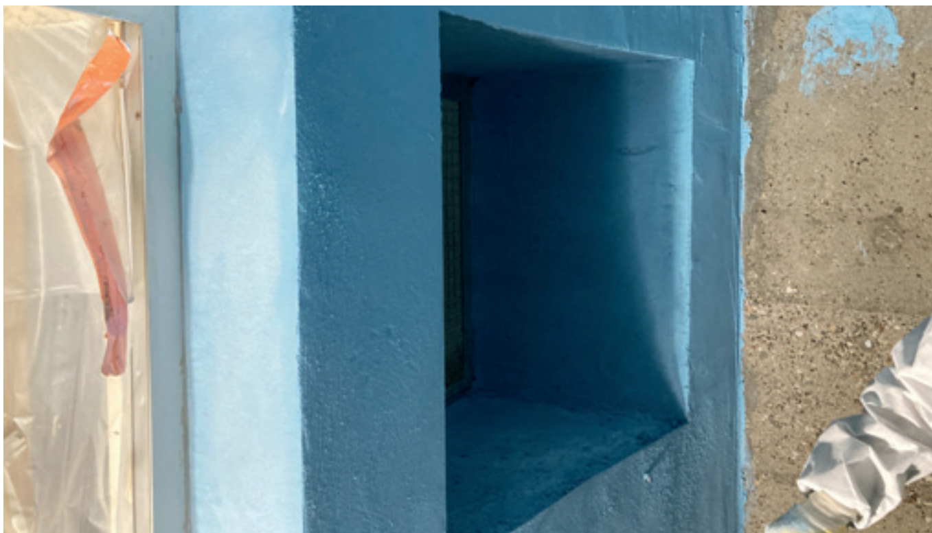
Abb. 54: Während der Beschichtungsarbeiten
