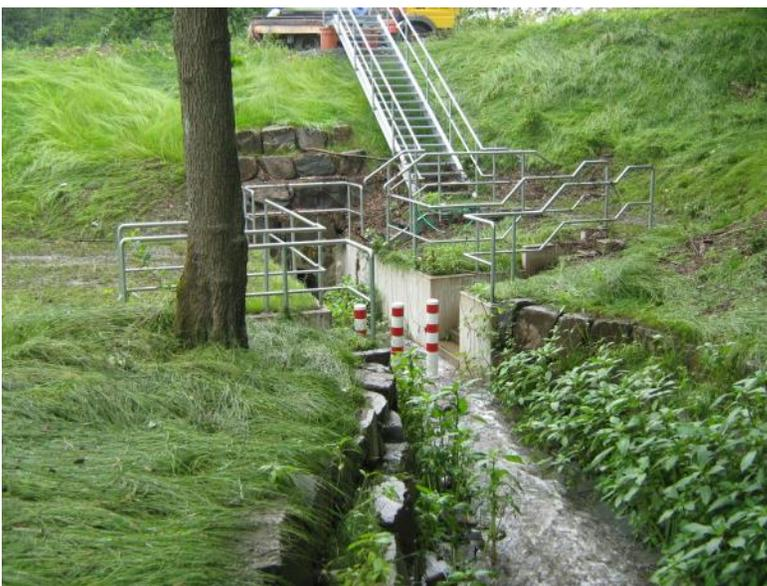
Abbildung 31: Neue Einlaufgestaltung Dammfuß mit Treppenanlage
