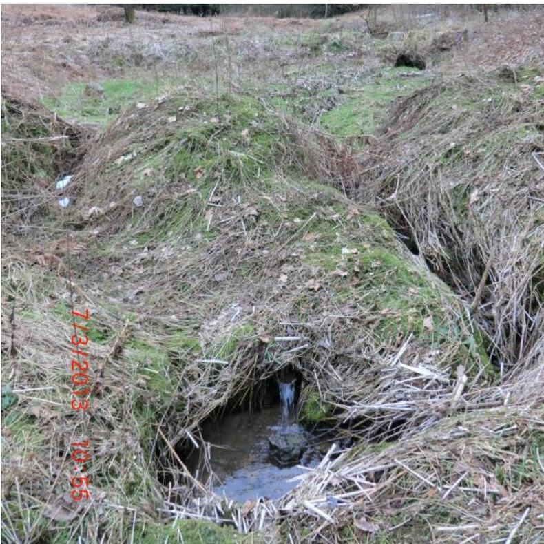
**Abbildung 21:** Einbauten (Betonrohre) und teilweise stark eingeschnittenes Gewässer (vorher)
