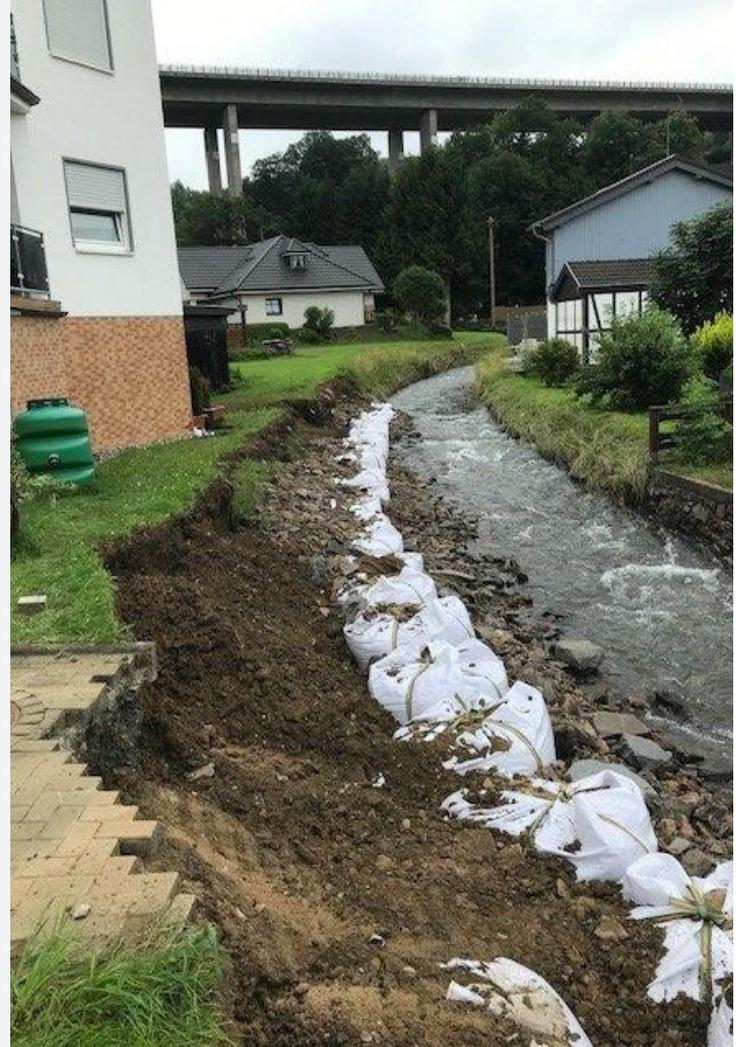
**Abbildung 14:** Erste Sicherungsmaßnahme nach dem Hochwasser in Engelskirchen-Loope
