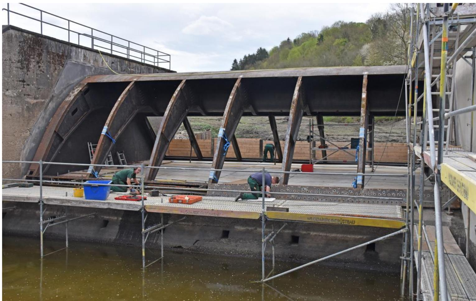
Abbildung 17: Vorbereitungsarbeiten Korrosionsschutz
