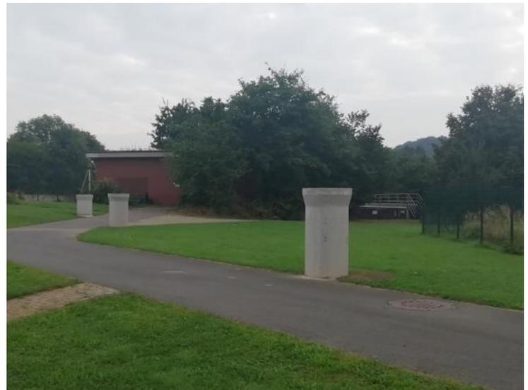
Abbildung 38: Kläranlage Donrath, Schachterhöhung
