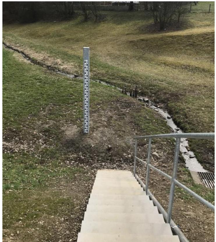
Abbildung 30: Neue Treppenanlage mit Lattenpegel
