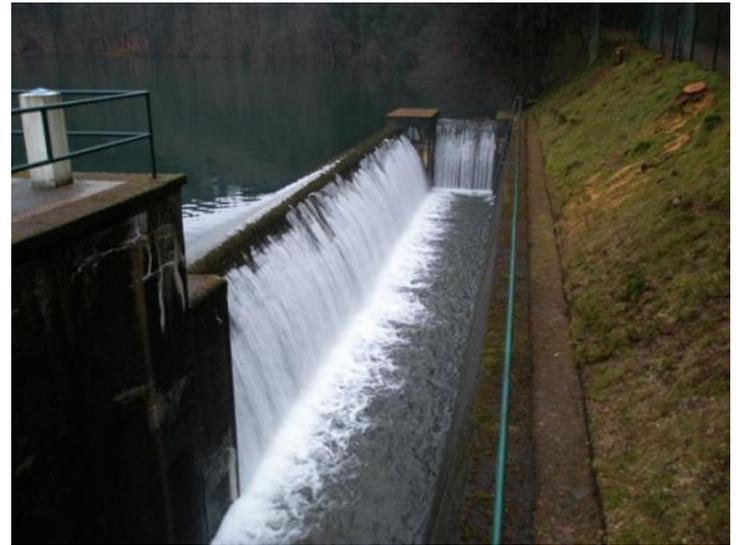
Abbildung 3 Hochwasserentlastung Genkeltalsperre in Betrieb
