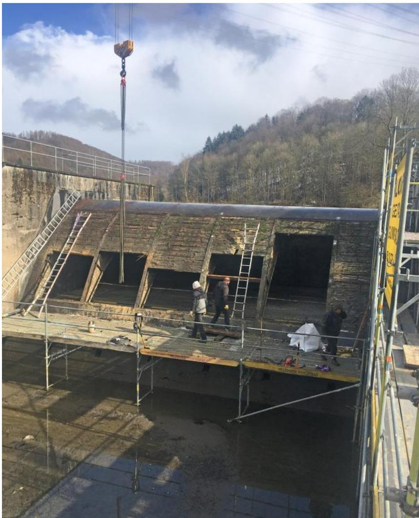
Abbildung 16: Ausbau der Beplankung
