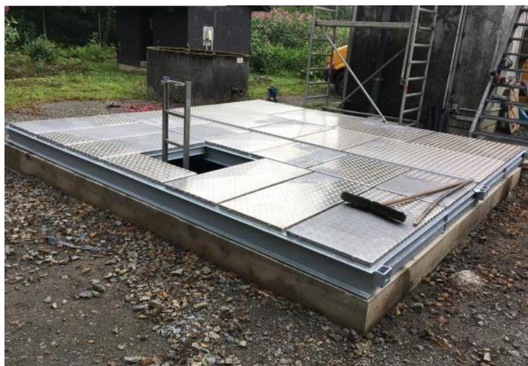
**Abbildung 52:** Montage und Fertigstellung der neuen Abdeckung Pumpenschacht
