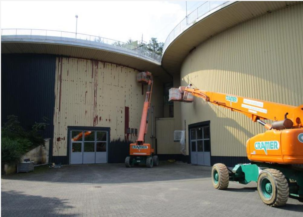
**Abbildung 75:** Erneuerung der Fassaden an den Reaktoren am Wasserwerk Auchel
