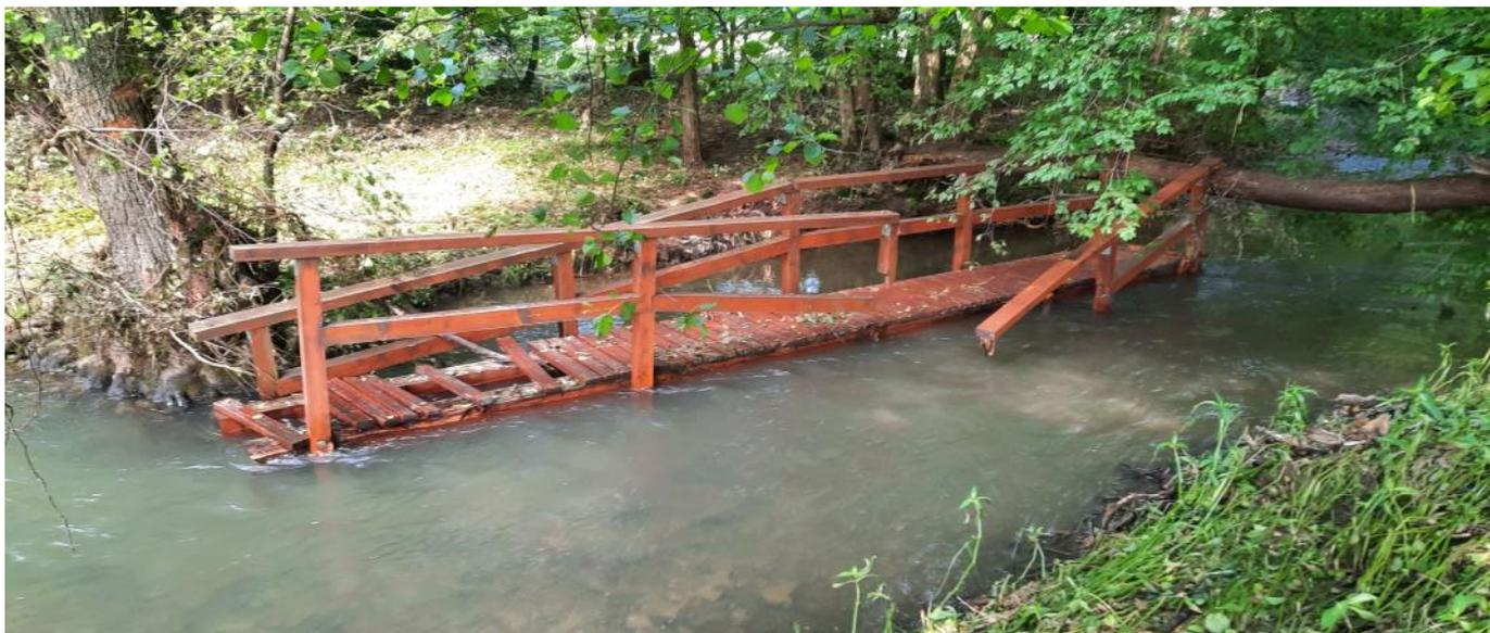
**Abbildung 5:** Abgerissene Messbrücke durch Baum gestoppt, ca. 80 m unterhalb der Pegelanlage
