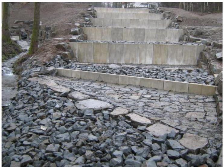
Abbildung 32: Neue Überlaufschwelle mit Ablaufkaskade
