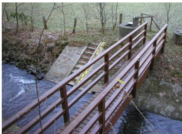
**Abbildung 6:** Pegel Kreuznaaf mit Messbrücke vor dem Hochwasser
