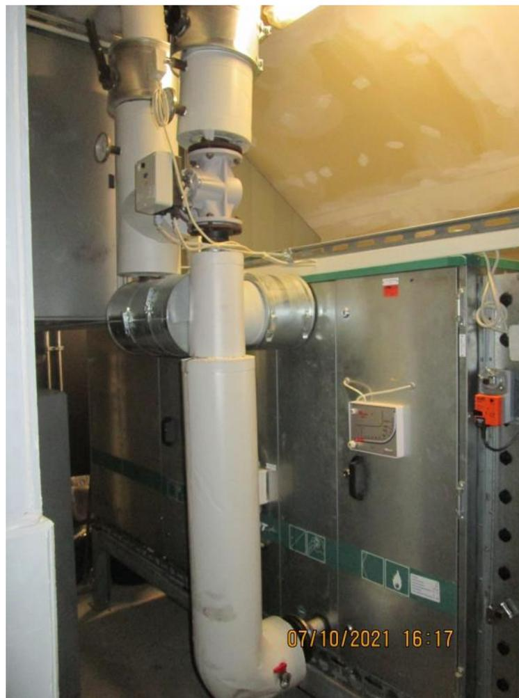
Abbildung 49: Lüftungsanlage im Labor
