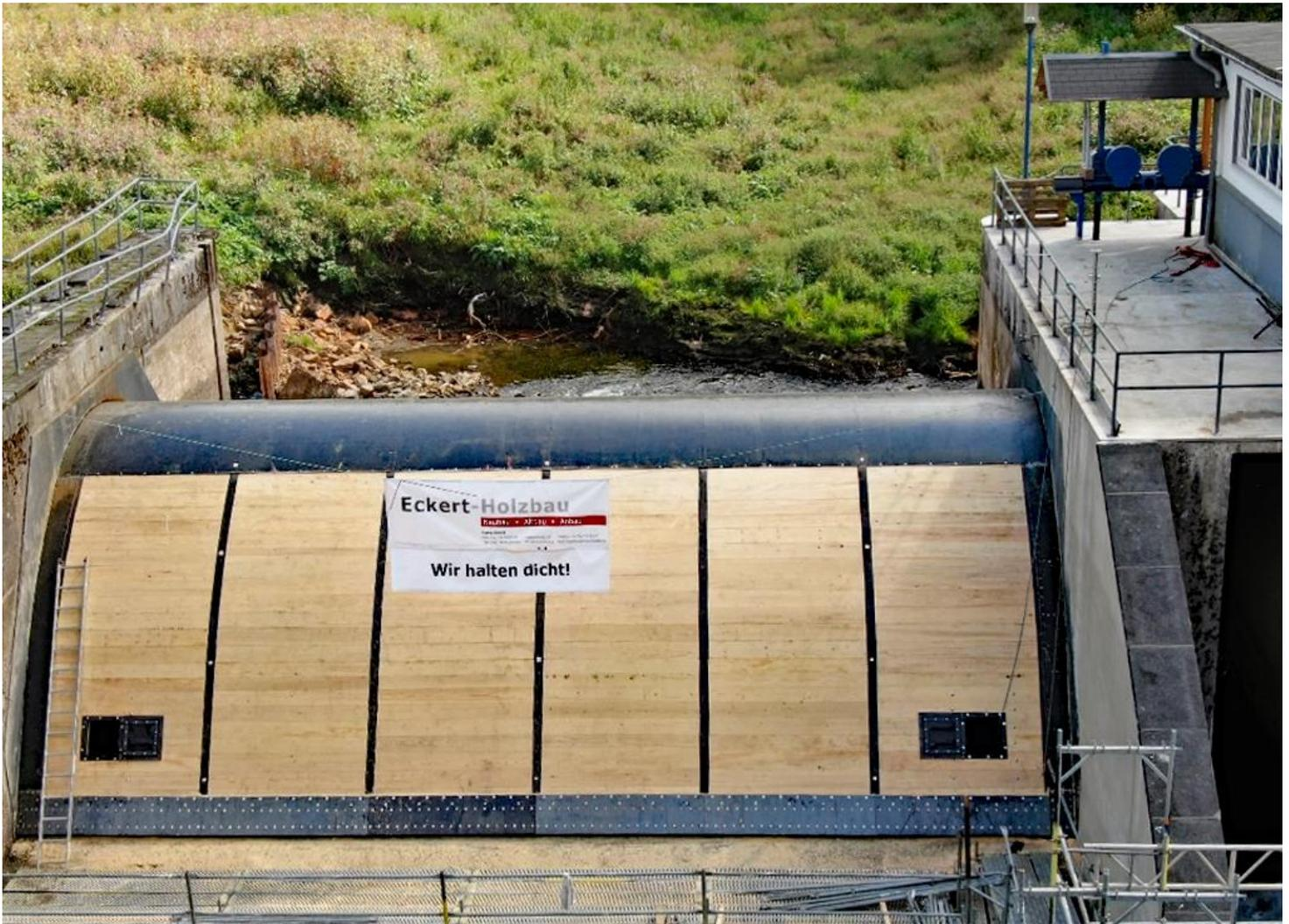
**Abbildung 18:** Dachwehr nach Abschluss aller Arbeiten
