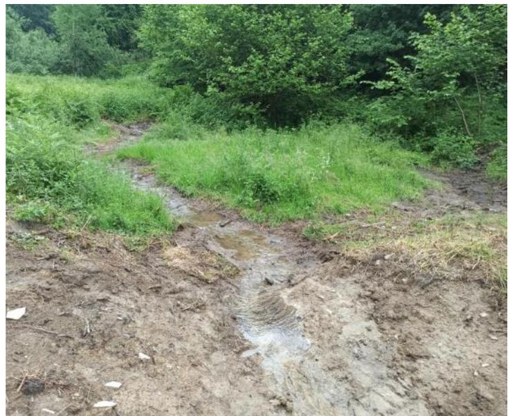
**Abbildung 22:** renaturiertes, flach modelliertes Gewässerprofil mit Ausuferung in die Fläche (nachher)
